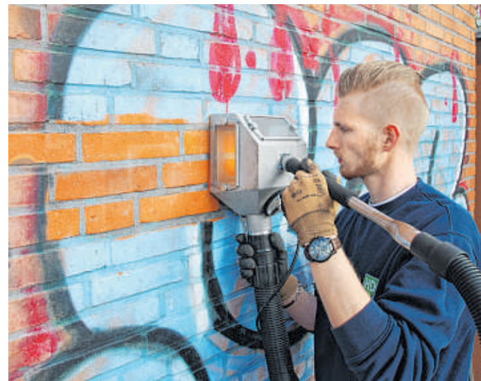
Geselle Timo Meyer entfernt ein Graffiti mit dem besonders umweltschonenden Unterdruck-Strahlsystem „Tornado“. Foto: Löbenbrück
